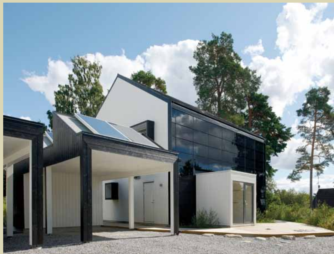
PLUSHUS. Kontoret har ritat huset Brighter Living i fyra varianter för typhustillverkaren A-hus. Husen genererar mer energi än de förbrukar.
